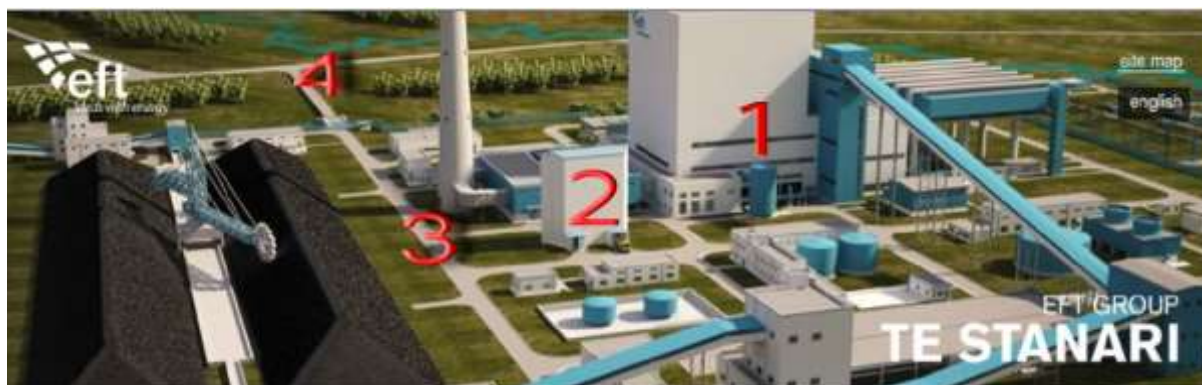
Слика бр. 9. Положај бункера пепела са дна котла (bottom ash-1) и летећег пепела (fly ash-2), у кругу ТЕ Станари
