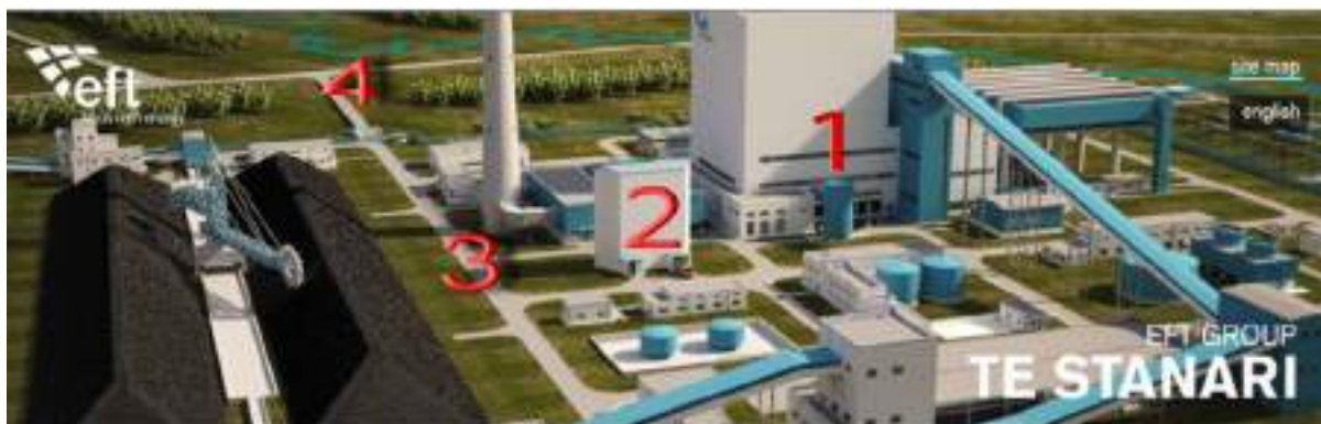
Слика бр. 7. Положај бункера пепела са дна котла (bottom ash-1) и летећег пепела (fly ash-2), у кругу ТЕ Станари
