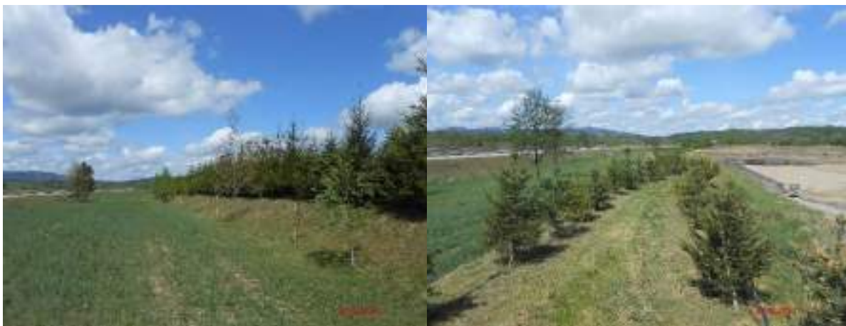
Слика бр. 9. Насип између одлагалишта и сусједних парцела направљен ради умањења негативног визуелног утицаја
