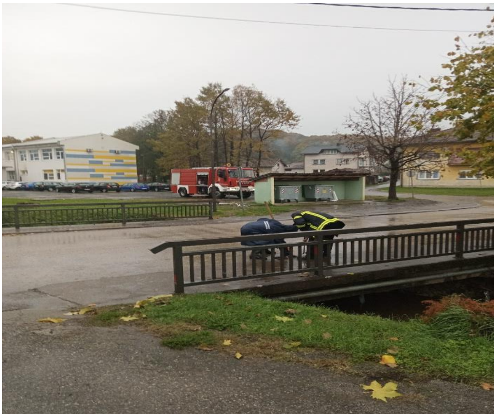
Слика 12. Спровођење активности и задатака јединице цивилне заштите – прочишћавање одводног шахта.
